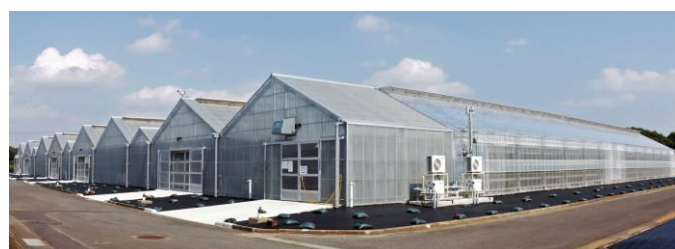
鉄骨ビニールハウス
